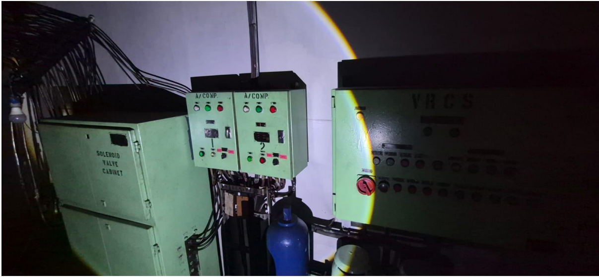
الصورة 36: وحدة التكييف المركزي
