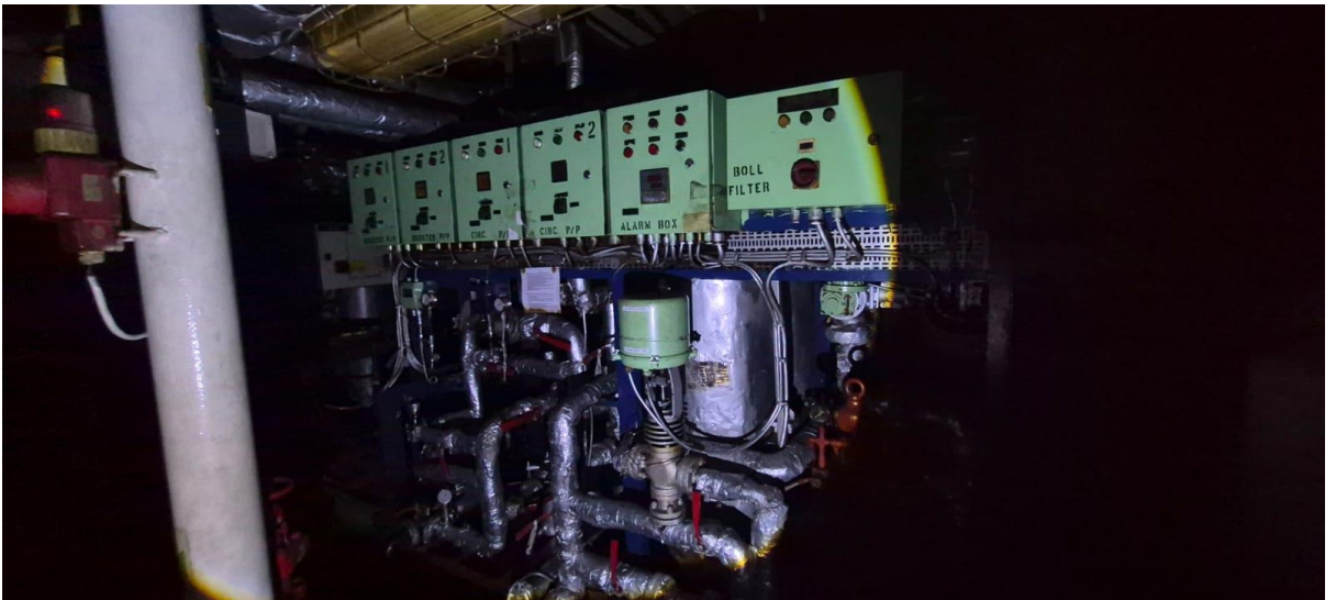
الصورة 34: مضخات زيت الوقود الثقيل
