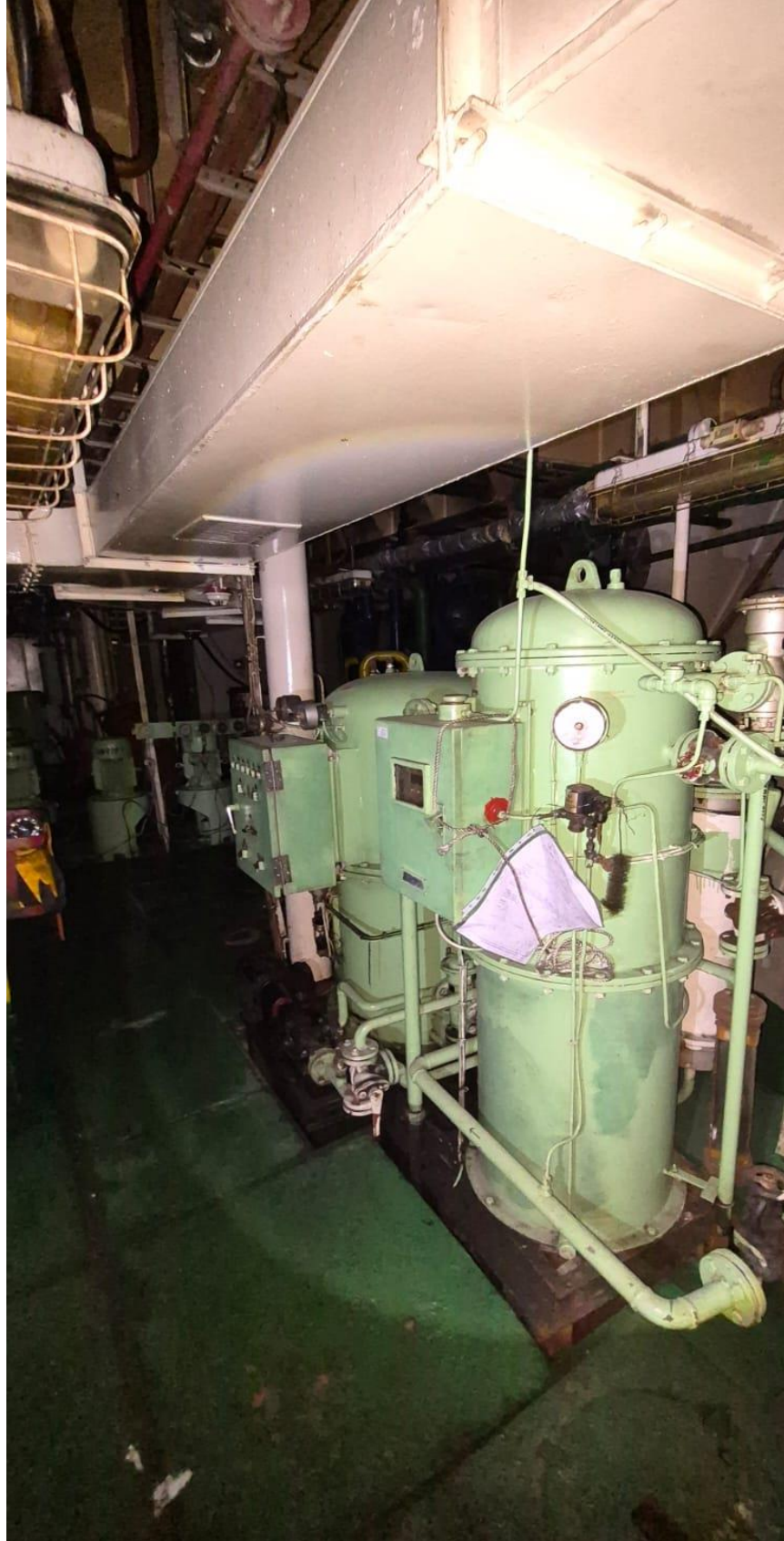
الصورة 35: فاصل مياه السنتينه
